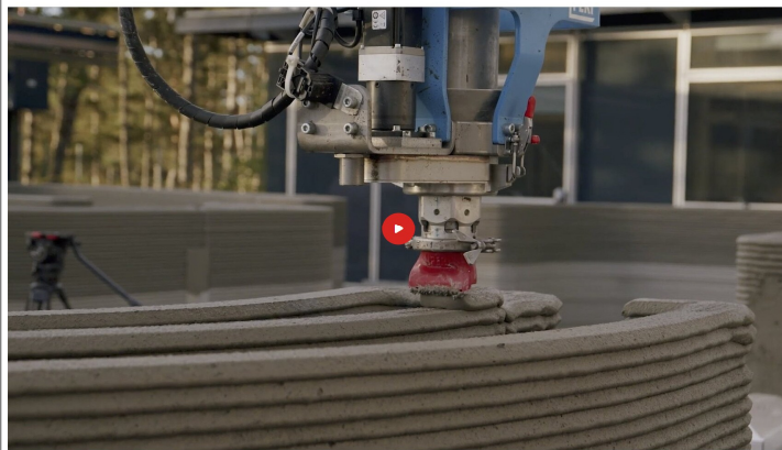
System 3D Druck | Beispiel Strabag
