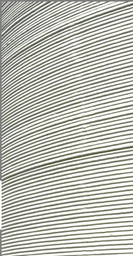
Struktur einer 3D-gedruckten Fassade mit Faserbeton
