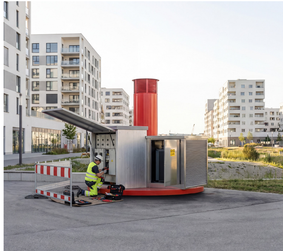
Unterhalt Trafostation Stadterweiterung Seestadt Aspern
